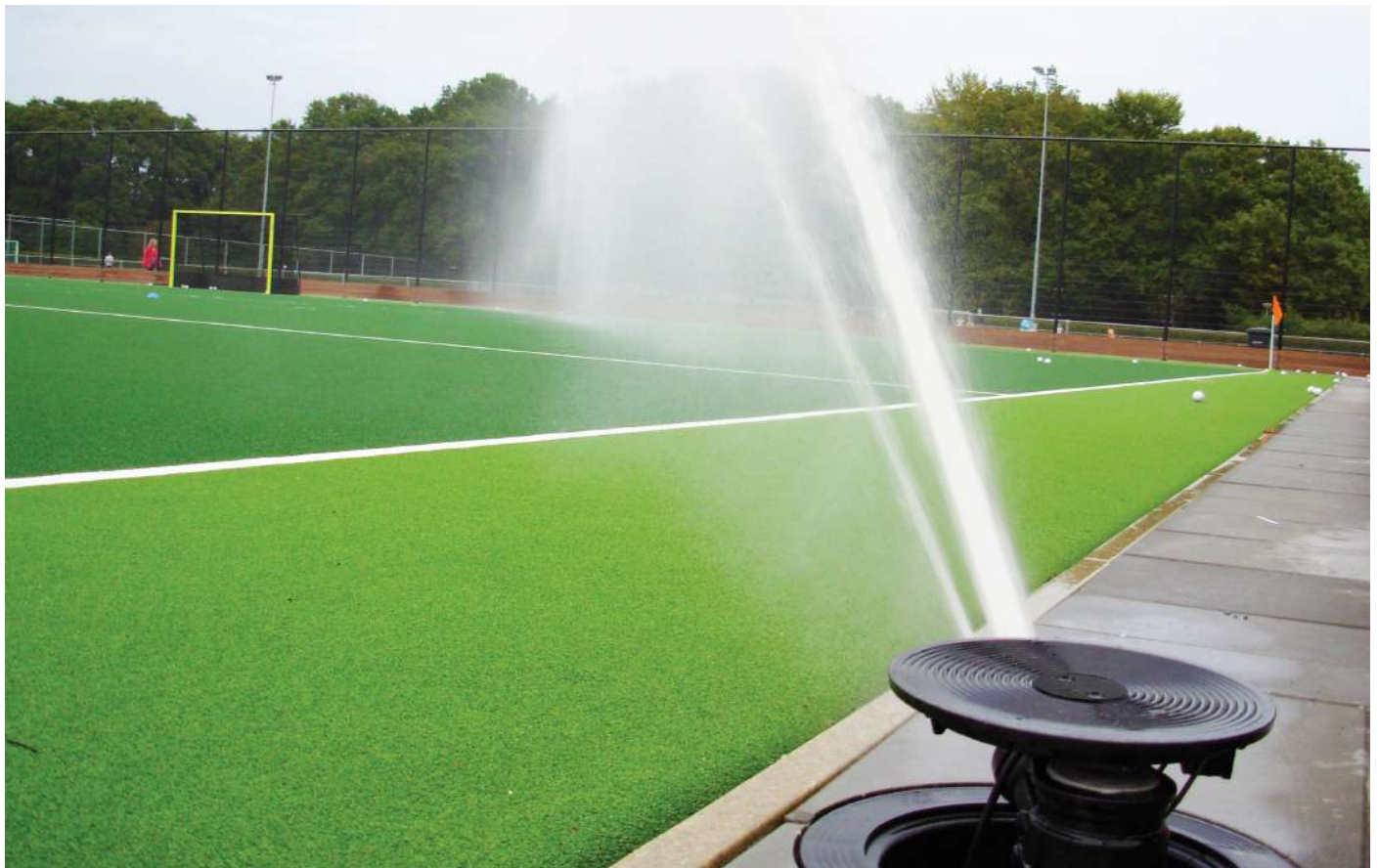
Cañón PERROT VP3 en funcionamiento.
